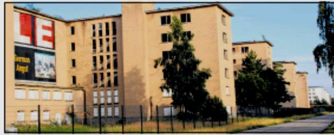
Der nördliche Teil des Blockes V gehört dem Landkreis Vorpommern-Rügen und soll nach einem Kreistagsbeschluss nun verkauft werden. Weitere Gästebetten möglich . . .
